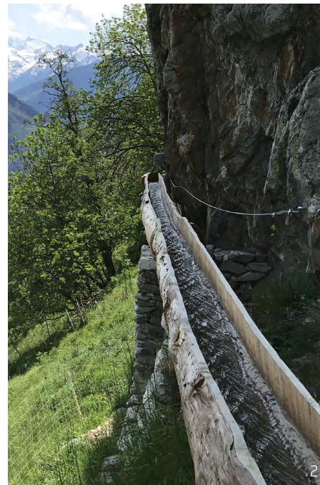
Abbildung 2: Wasserwasserleitungen werden je nach Region auch Suonen, Wasserleiten oder bisses (franz.) genannt. Das Wasser wird meist aus Bächen abgezweigt, die durch höhergelegene Quellen, Schneefelder und Gletscher gespeist werden. Über teils spektakuläre Bauten wird es in tiefere Lagen geleitet, wo es zur Bewässerung von Wiesen, Reben oder Obstkulturen genutzt wird. (Foto: Karina Liechti)
