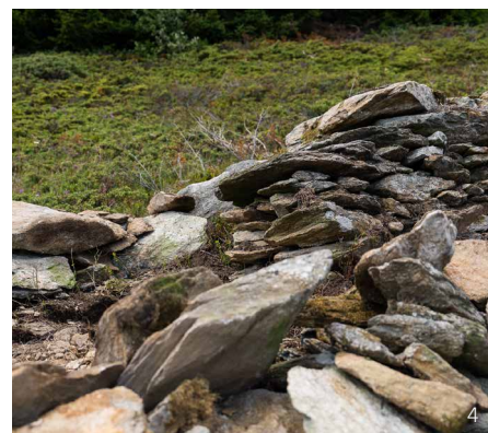
Abbildung 4: Durch den fehlenden Unterhalt zerfallen Trockenmauern nach und nach. (Foto: Nico Renggli)
