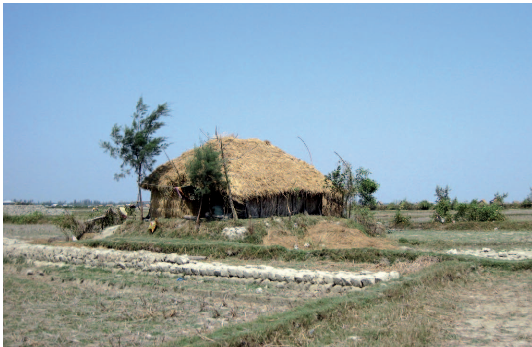
Para protección de inundaciones, casas son construídas en montículos de tierra. © Judith Rosendahl
