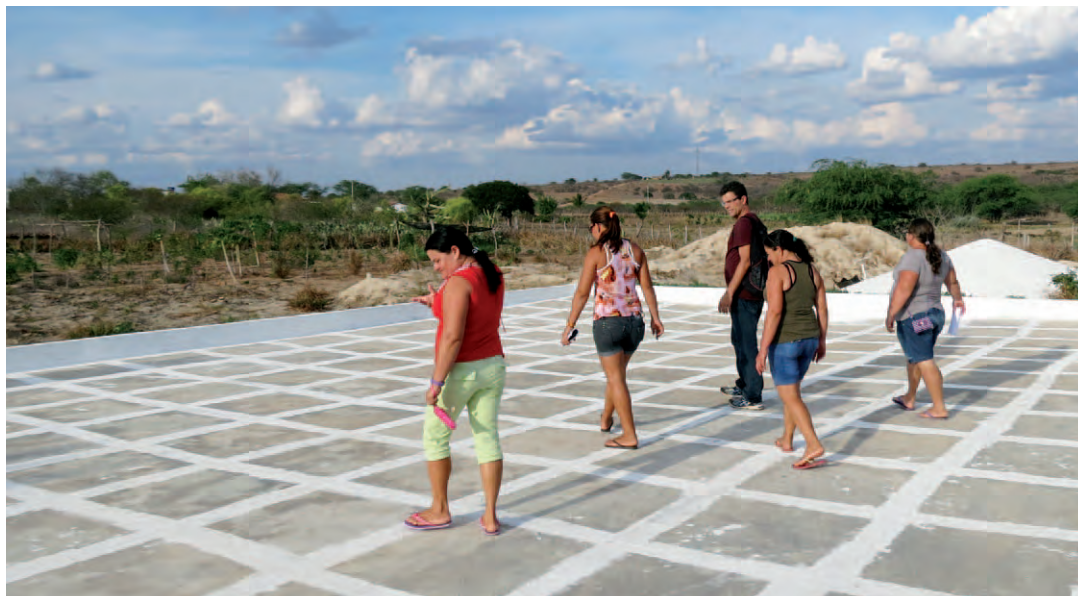
Des citernes en ciment sont construites pour la collecte de la pluie. © Matheus Alves Zanella
