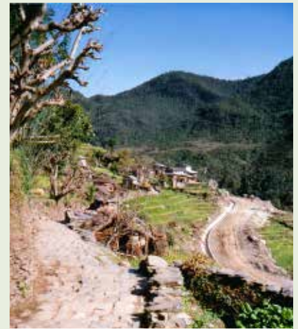
Construcción de carretera moderna respetando el sendero existente. Carretera Pokhara-Baglung, Nepal, 1990 (G. Schneider)
